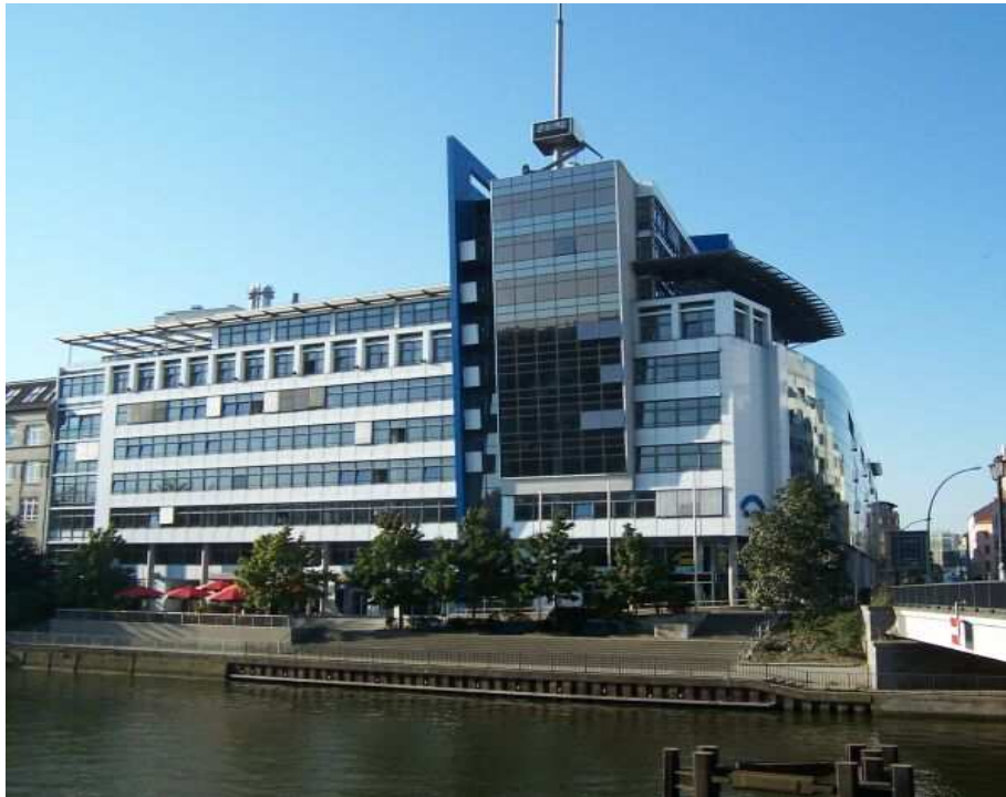
Gebäude der Senatsverwaltung in der Brückenstraße 6, Berlin-Mitte
