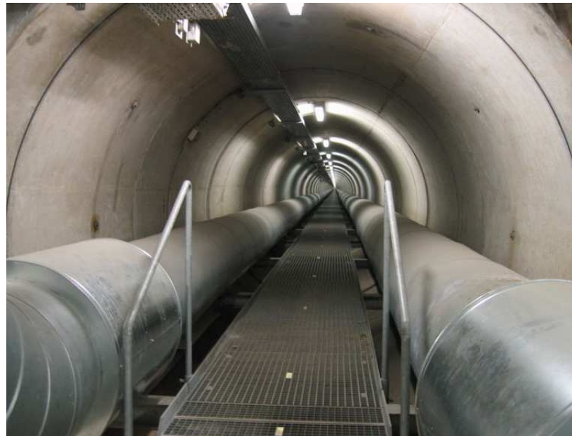
Fernwärmehöhle unter dem Rhein in Köln (Foto: Frank Spakovski)
