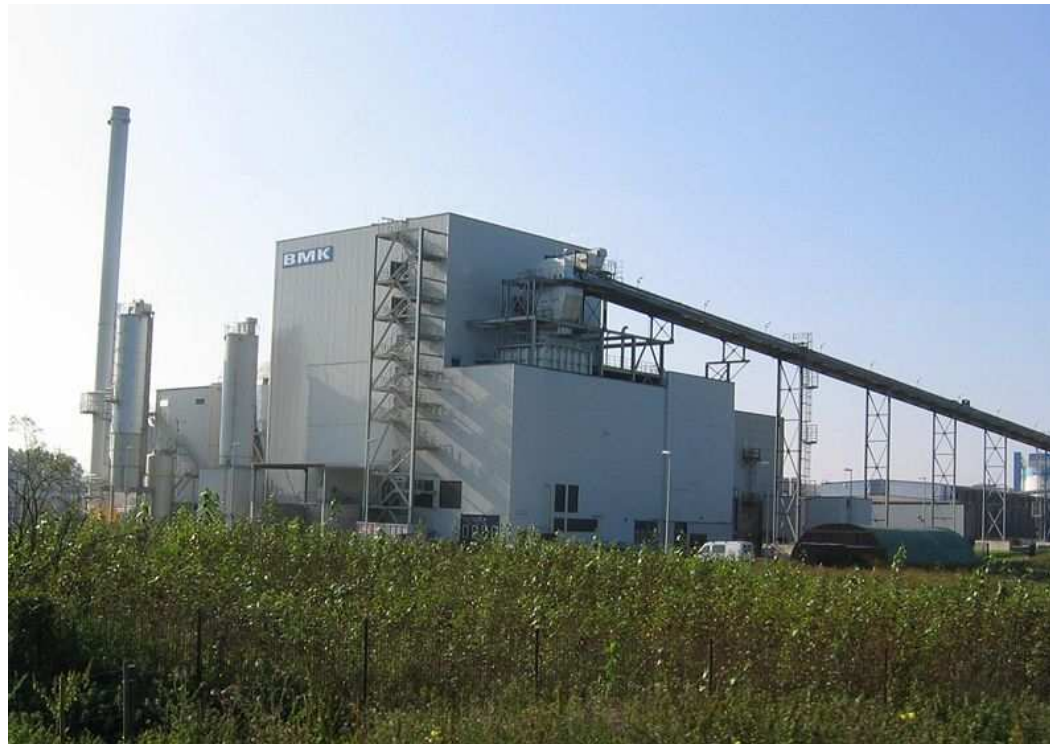
Biomasse-Heizkraftwerk Lünen (Foto: Rainer Sielker)
