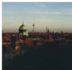
Nahwärmeversorgung „Bremer Höhe“
