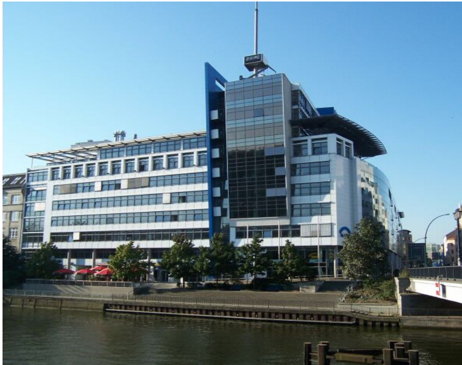
Gebäude der Senatsverwaltung in der Brückenstraße 6, Berlin-Mitte
